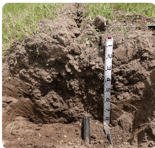
▲ 施工後断面(深さ800mm)
